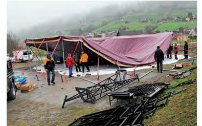
Das Zelt nimmt Formen an: Die insgesamt 31 Rondellstangen stehen schon fast alle. Noch nicht gesetzt sind die Masten.
