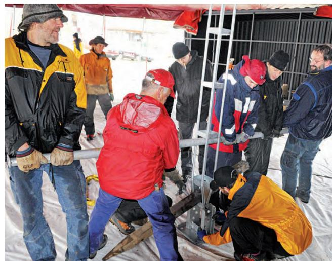
Mit vereinten Kräften II: Ein Zeltmast wird angehoben und zwecks Ausgleiche der Niveauunterschiede mit Holz unterlegt.
