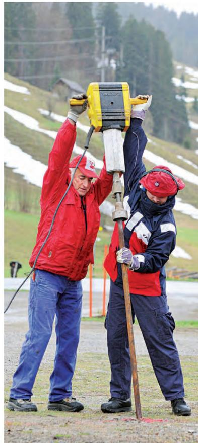
Nützliches Hilfsmittel: Mit vereinter Kraft und einem Kompressor werden die riesigen Erdanker in den Boden getrieben.
