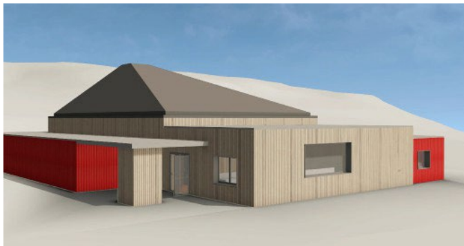
Blick von Südwesten
